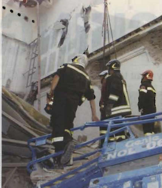
CRUMBLING ITALIA: The Palazzo delle Esposizioni collapse
